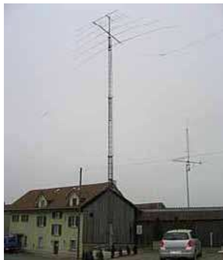
Bild 2: KW- und UKW-Antennen von HB9TG beim Restaurant Immenberg
